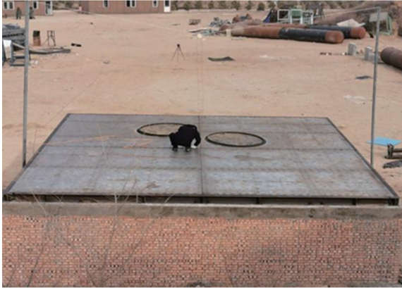
(b) 洞口封堵结构俯视图
