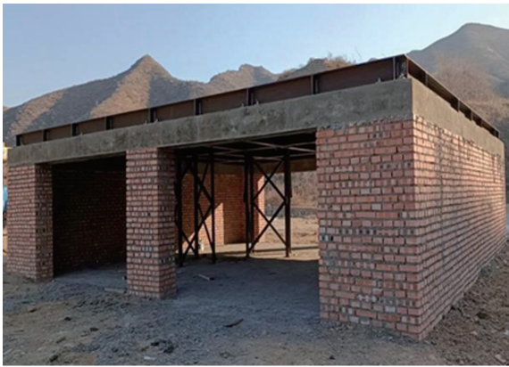
(a) 洞口封堵结构正视图
