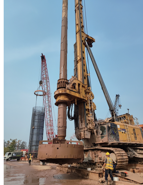
图10 钻机在特制钢结构平台上施工
