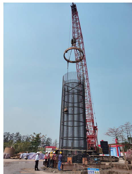
图 13 钢筋笼安放现场施工
