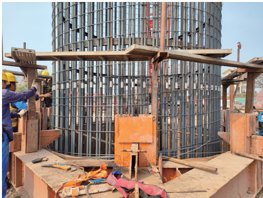
图 16 钢筋笼对接区段布设箍筋
