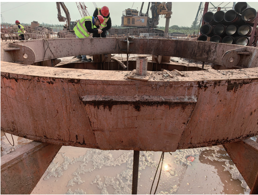
图 3 钢筋笼吊筋与吊环连接
