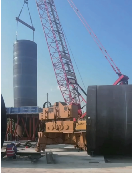
图8 吊车吊放护筒
