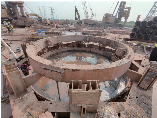
图 18 钢筋笼固定完成
