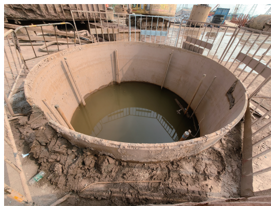
图 20 解除吊筋和吊环的连接
