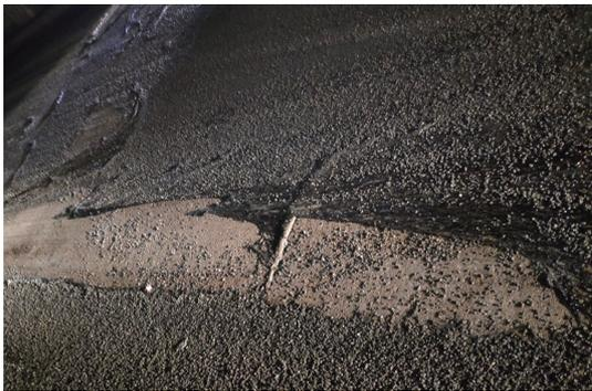
图 1 封层剥落
