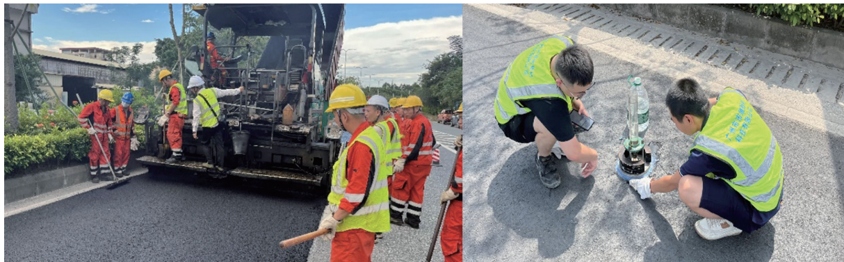
图2 全比例温拌再生沥青混合料试验段现场
