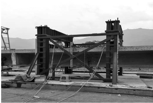
图 4 单梁加载现场
