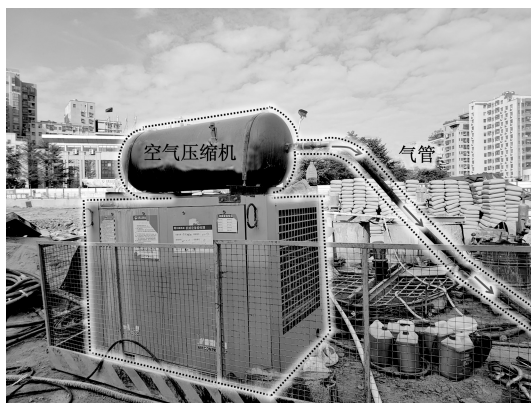
图6 气管连接空气压缩机
