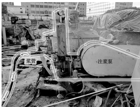
图7 浆管连接高压注浆泵
