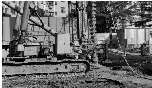
图5 桩机基坑边就位
