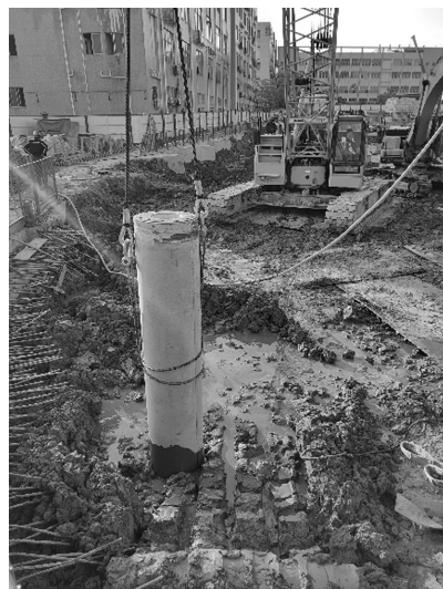
图 15 管桩吊放至浆孔
