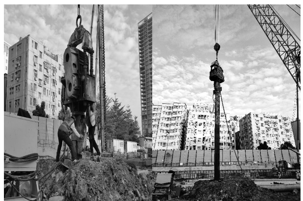
图19 振动锤于工艺孔内夹持送桩器
