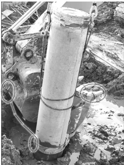
图16 钢丝绳、吊装带与铲斗配合
