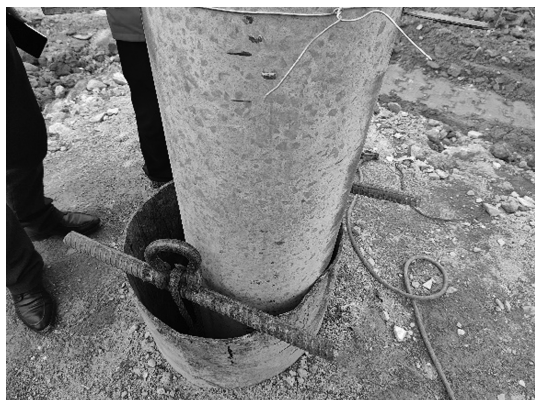
图 12 管桩孔口固定
