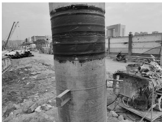
图 13 管桩接长效果
