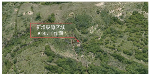
图 15 30507 工作面新增裂隙实景模型
