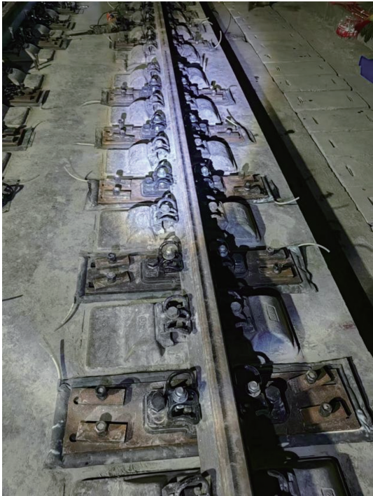
图 7 临时支撑系统安装完成后效果
