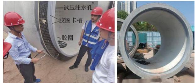
图 8 再生水管道构造及实物
