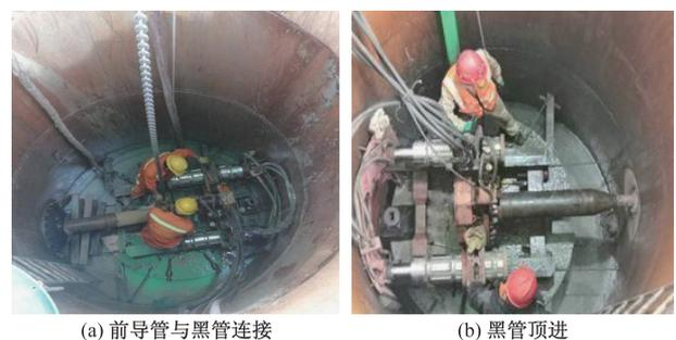
图 11 黑管顶进示意图
