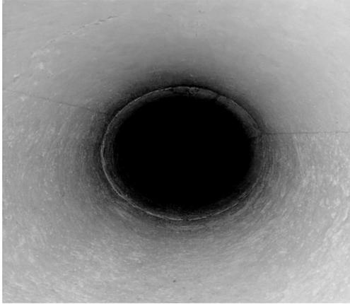
图 15 贯通后的管道内部 CCTV 检测
