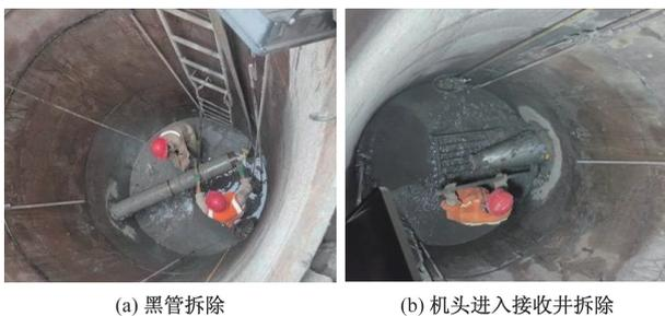
图 13 黑管、机头拆除示意图
