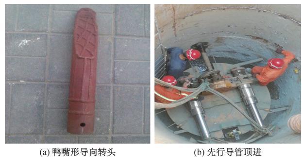
图 10 先导管顶进示意图
