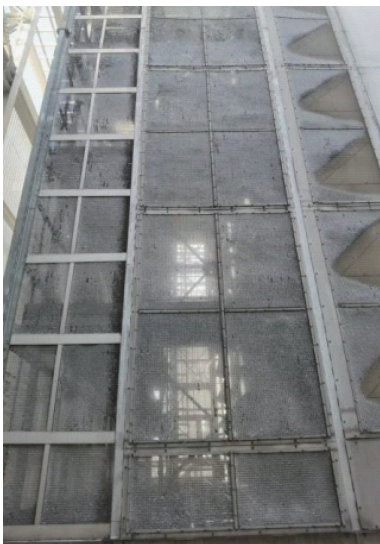
图 1 燃机罩壳滤网外观
