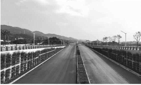
图 15 重庆明月大道装配式生态扶壁挡墙实景
