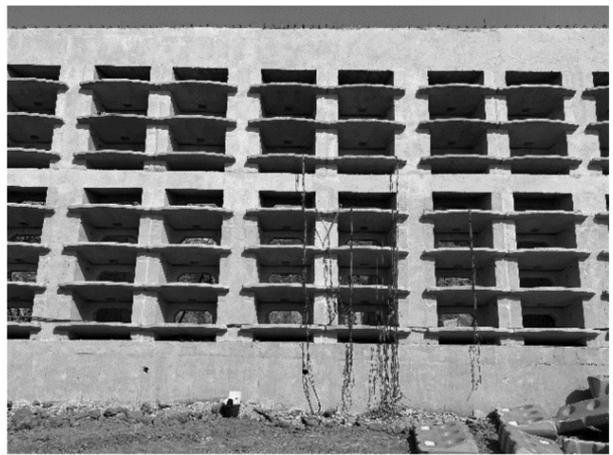
图 8 装配式生态挡墙正面
