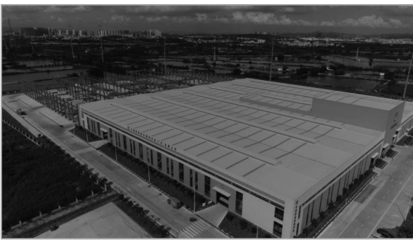
图 2 广州花都 PC 构件厂项目航拍图
