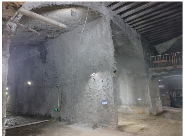
图 5 甘露园站中导洞形式
