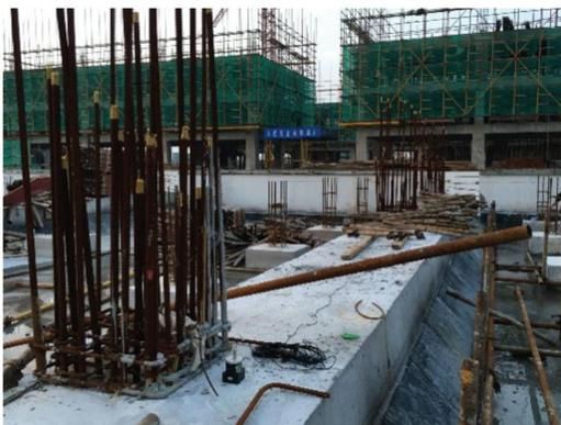
图2 柱顶部振动测点
