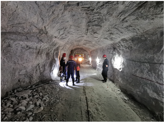
图 15 -100 m 中段巷道施工现场
