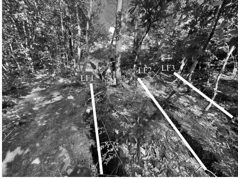
图3 滑坡后缘裂缝
