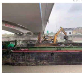
(b) 挖泥船作业
