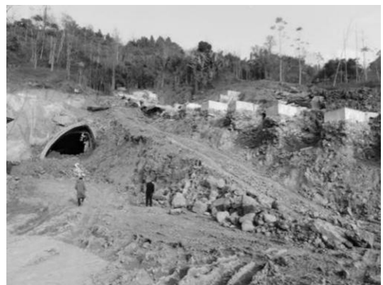
图 9 工程治理施工现场
