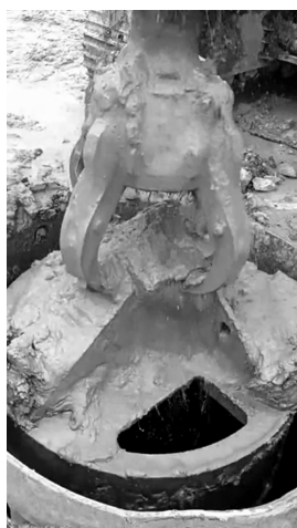
图11 提升掉落钻头至孔口
