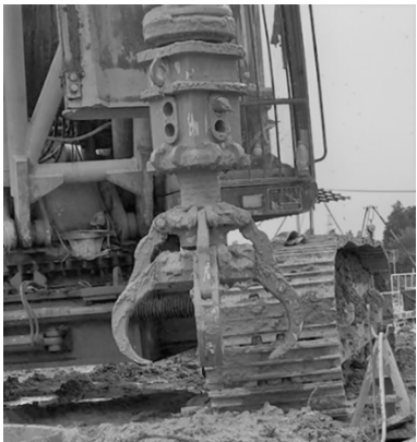
图 8 机械手安装完成
