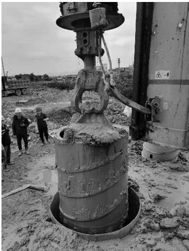
图 6 机械手打捞钻头实例
