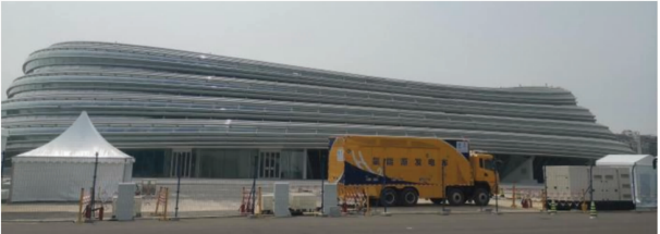
图 8 氢燃料电池发电车现场应用照片
