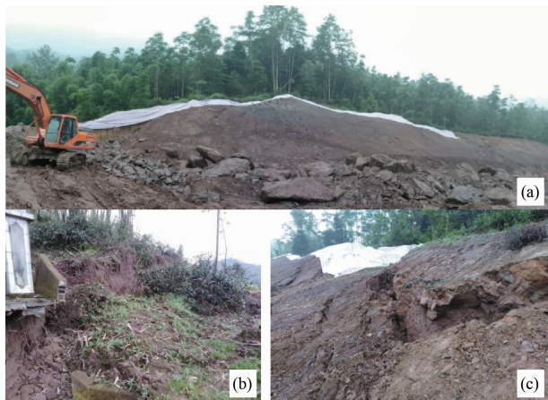
图 4 复活区后缘裂缝
