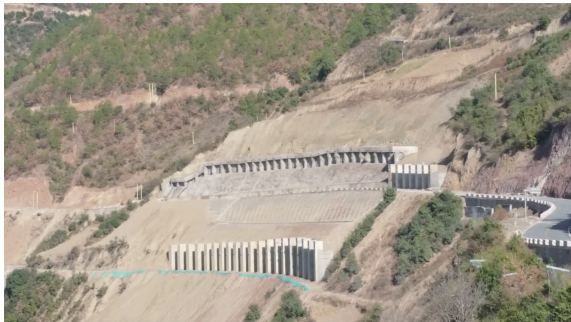
图 15 滑坡治理竣工后全景(2014 年 12 月)
