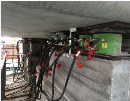
图 4 顶升平移纠偏系统布置
