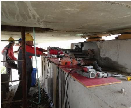
图 2 支座内侧锚固螺栓凿除
