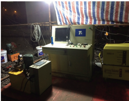
图 5 箱梁顶升及平移
