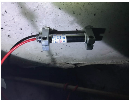
图 6 轨道结构应力监测
