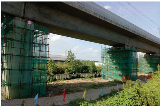
图 8 京沪高铁秦淮河特大桥桥梁偏移整治工程施工现场
