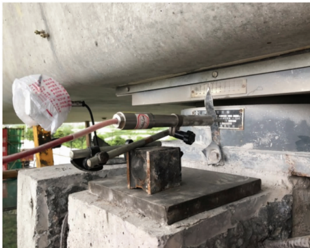
图 7 箱梁结构位移监测
