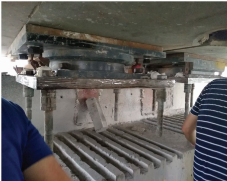
图 3 临时支座安装
