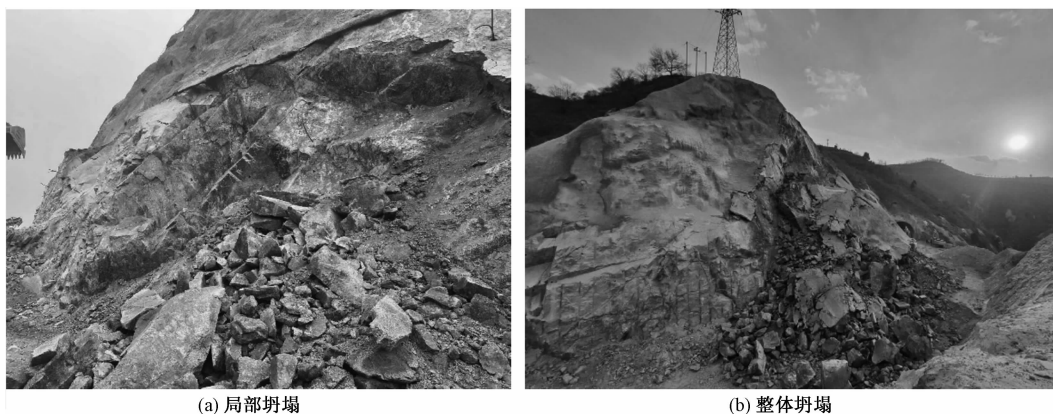
图 8 现场边坡坍塌照片
