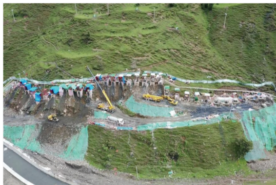
图1 某滑坡体抗滑桩边坡
