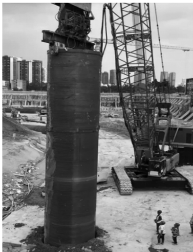
图 3 振动锤下放护筒
