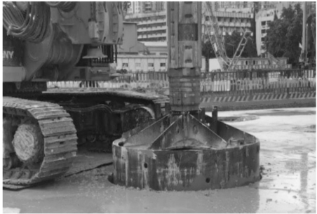
图 14 旋挖钻机引孔
