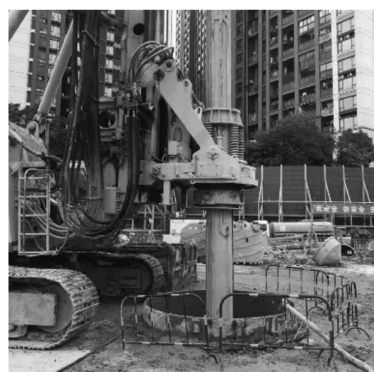
图 22 旋挖钻机钻进成孔
