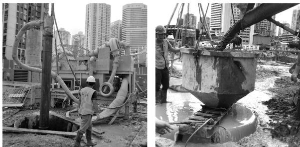
图24 二次清孔、灌注桩身混凝土
