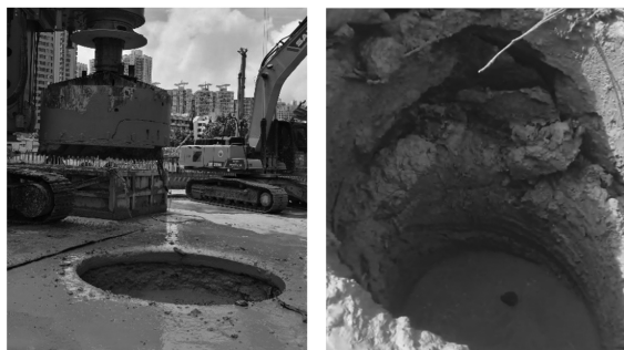
图1 旋挖钻机预成孔
