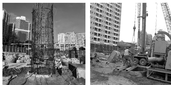
图 23 安放钢筋笼和灌注导管
