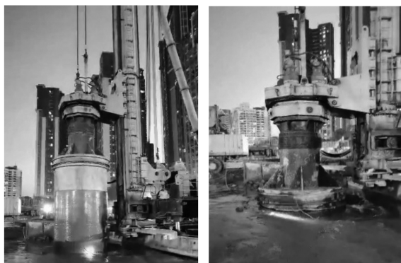
图 20 长护筒回转钻进
