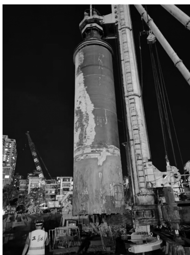
图25 起拔护筒
