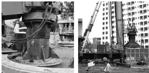
图 17 钻机与特制接驳器连接
