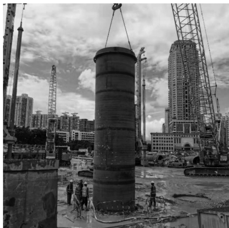
图 16 吊放长护筒
