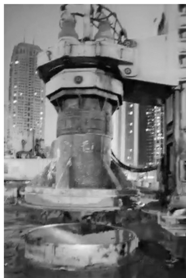
图 21 钻机与护筒分离
