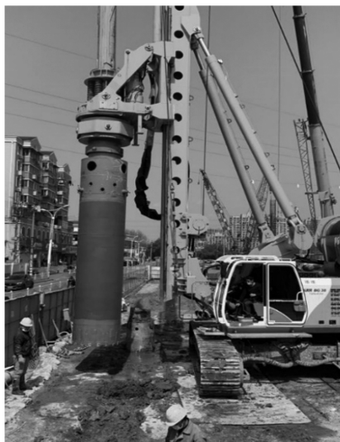
图 2 旋挖接驳器全护筒安放
