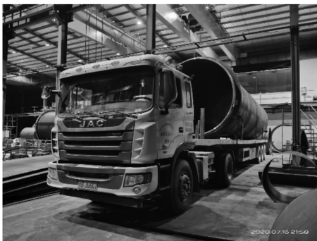
图 15 运送特制长护筒至施工现场
