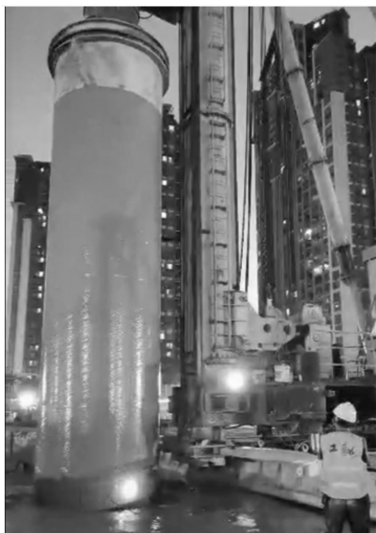
图 19 多功能钻机与长护筒连接
