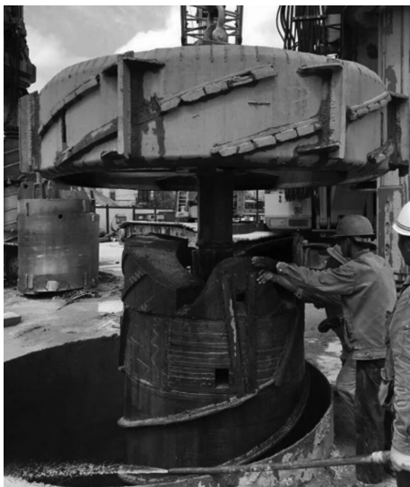
图 14 上扶正钻头钻进施工先导孔
