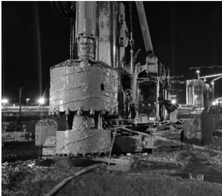
图 19 第三级下扶正钻头导向钻进入岩
