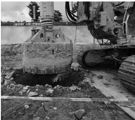
图 10 旋挖钻机预引孔
