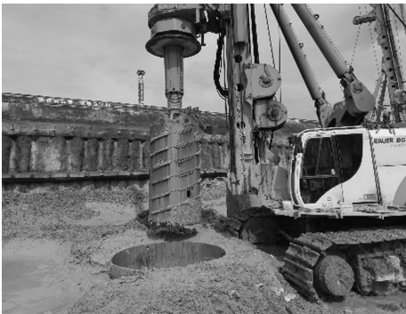
图 15 1 600 mm 牙轮钻筒第一级钻进入岩
