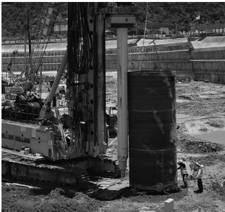
图 11 竖直吊放护筒
