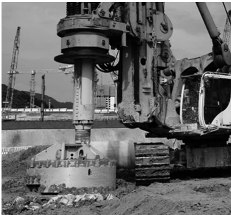
图 21 2 400 mm 旋挖钻斗整体清孔捞渣
