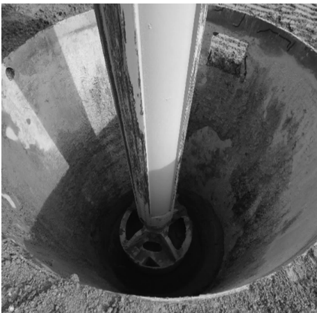
图 12 1 600 mm 旋挖钻斗土层段钻进成孔
