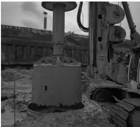
图 20 2 400 mm 截齿钻筒孔底削平
