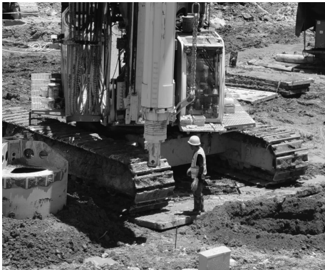
图 9 旋挖钻机下铺设行车道板
