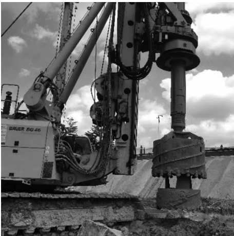
图 17 第二级下扶正钻头导向钻进入岩
