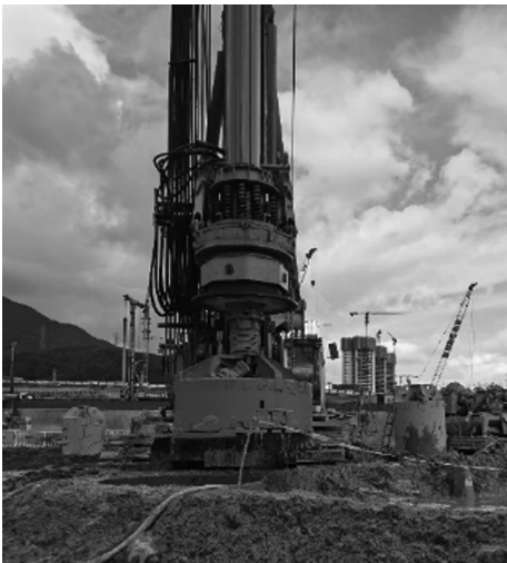
图 13 2 400 mm 旋挖钻斗土层段扩孔钻进
