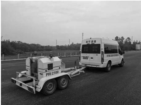
图 3 落锤式弯沉仪现场检测
