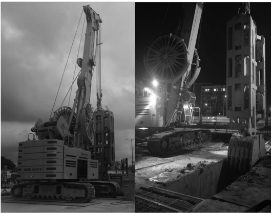
图 14 地连墙分三序抓土开挖成槽
