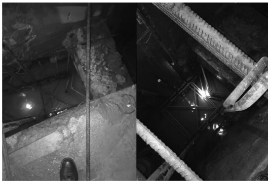
图 20 钢筋笼置入槽内与线缆位置关系
