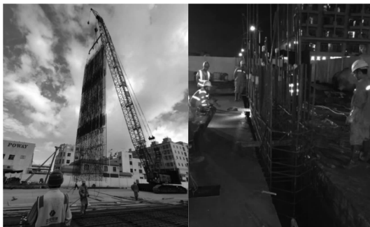
图 19 钢筋笼起吊下放入槽
