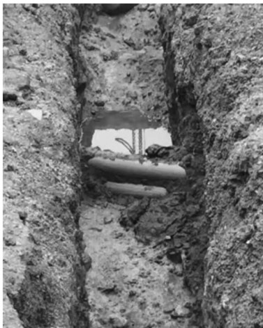
图 10 开挖探明地下管线
