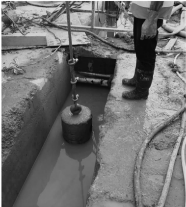
图 15 将冲锤吊入地连墙槽内
