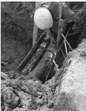
(a) 线缆保护示意图 (b) 线缆加固保护施工
