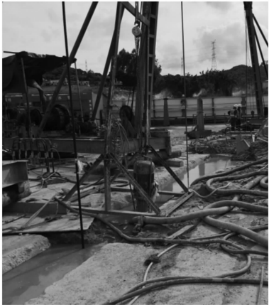
图 16 冲孔桩机施工破碎槽底岩层
