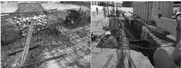
图 12 保护钢板两端伸入导墙中
