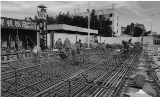
图 17 钢筋笼现场制作
