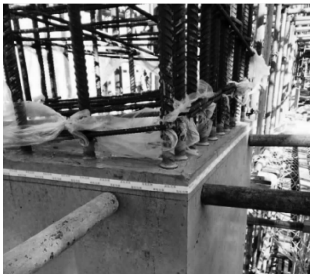
图 9 拼缝处防止渗漏
