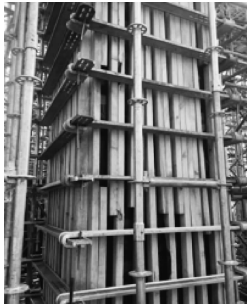
图 7 梁、柱模板加固
