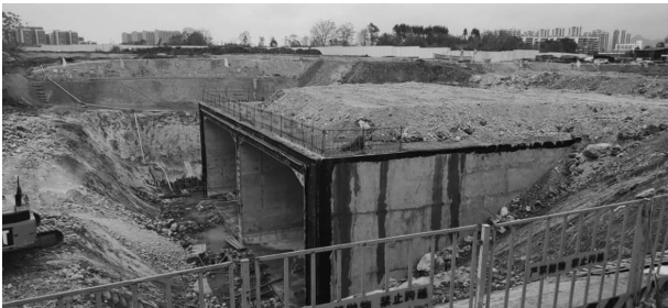
图 6 现浇钢筋混凝土框架涵
