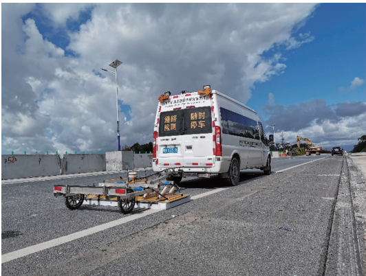
图 5 三维探地雷达检测现场
