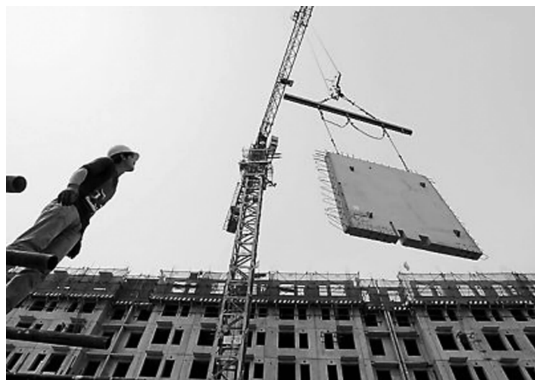
图 1 PC 构件吊装
