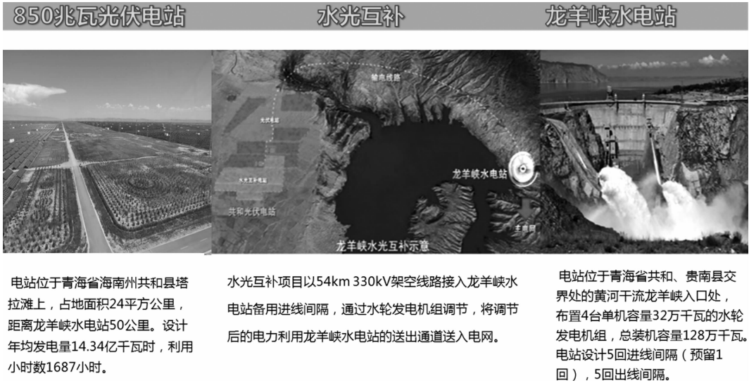
图 5 龙羊峡水光互补项目工程
