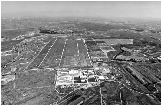
图 10 国家风光储输示范工程
