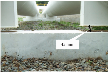
图 4 管托与管墩脱开
