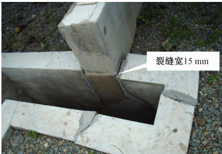
图 8 支墩与汇处排水沟拉裂
