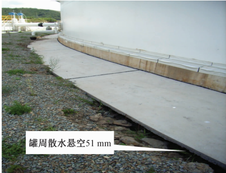
图 2 罐周散水底部被掏空
