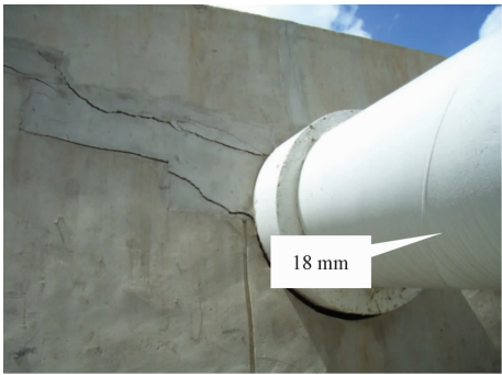
图 5 穿越隔堤的管线与隔堤拉
