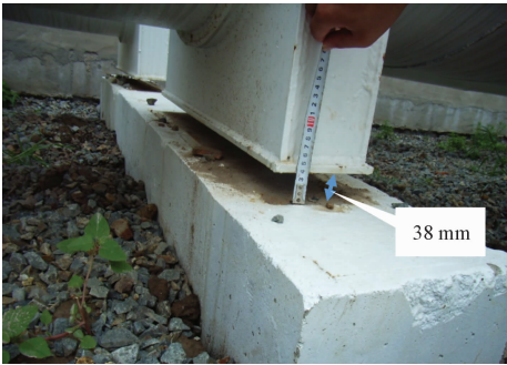
图 3 管墩下沉与管托脱开
