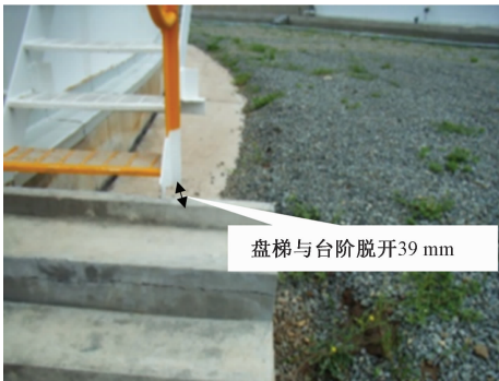
图 7 储罐盘梯与台阶脱开
