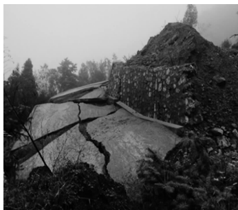
图5 滑坡损坏的公路
