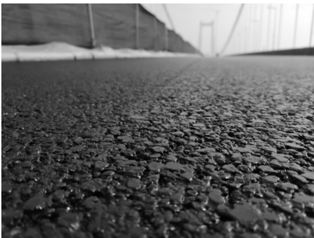
图 7 环氧沥青混凝土细部图
